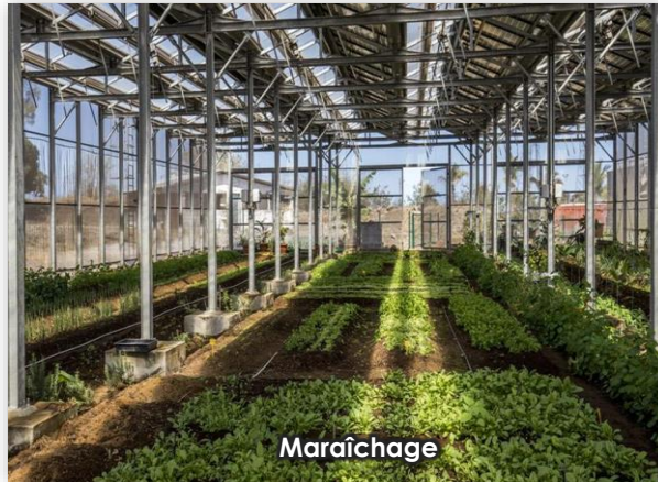
Serres photovoltaïques – Ile de la Réunion
